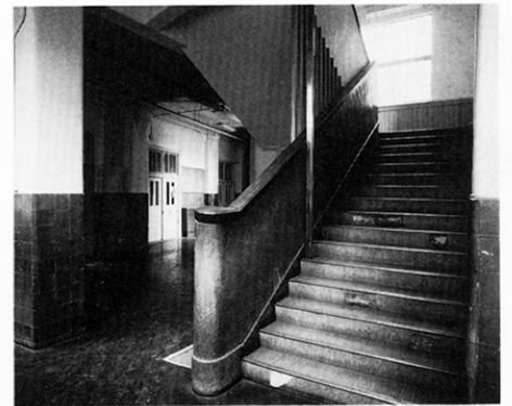
昭和3年、大震災の復興事業として建てられた歴史ある校舎
